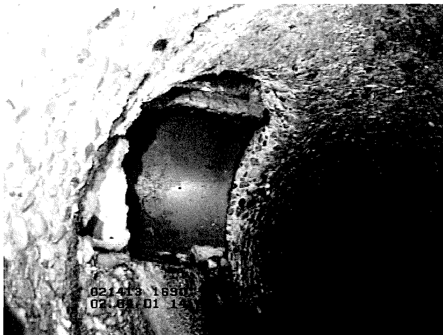
Foto einer Schadstelle
