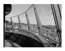
Vertikales Netz, Seil Ø 2,0 mm Typ CX
