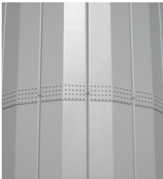
Horizontale Verbindung mit Pressmüttern, Ansicht von außen
