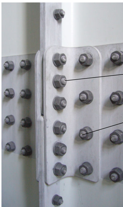
Turmverbindung vertikal und horizontal Ansicht von Innen
