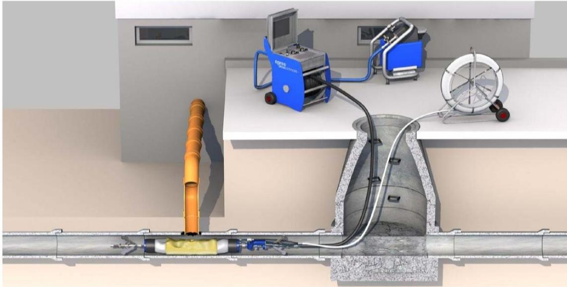
DrainLCR-S-Packer hinter den Stutzen schieben bzw. ziehen. Mit Hilfe der Kamera und des Drehantriebes den DrainLCR-S-Hebekorb in einer Flucht zum Seitenanschluss ausrichten.
