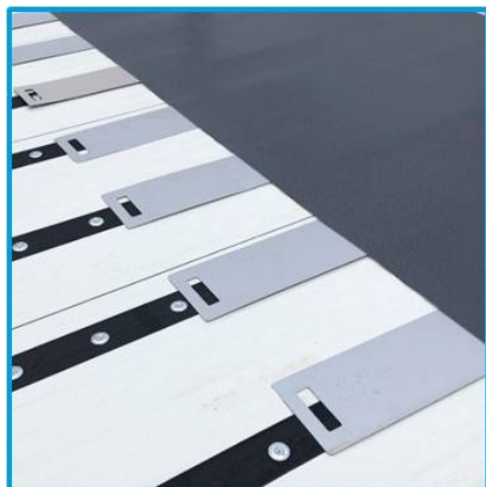
"BMI InnoGrip Bänder" werden vor der Bahnenverlegung mit "BMI InnoGrip Verlegeblechen" geschützt.
