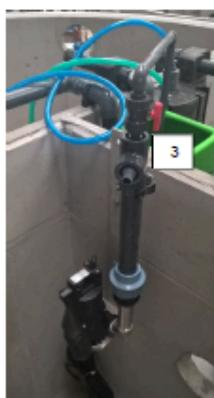
Nachrüstset Typ SanoSept zur Herstellung von Kleinkläranlagen mit einer dritten Reinigungsstufe zur Desinfektion des Abflaus mittels UV-Strahlung für 4 bis 50 EW; Ablaufklasse +H
