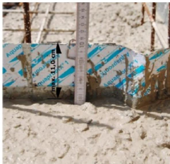
Einbindetiefe in den ersten Betonierabschnitt (= Bodenplatte) mindestens 3,0 cm.
